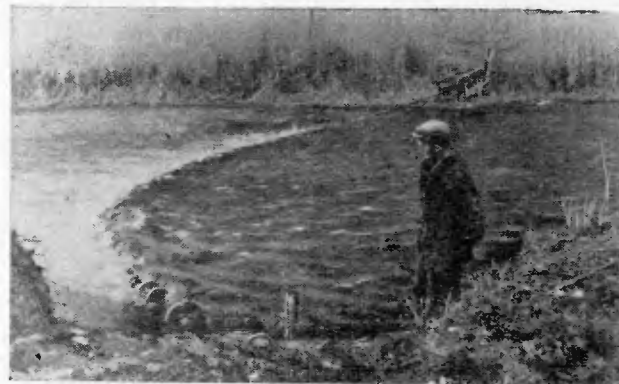
Рис. 2а. Общий вид действующей на р. Карасу гирляндной ГЭС на поперечных турбинах мощностью ( N_{ген} ) 1 квт. (установка используется для освещения лагеря изыскательской партии).
